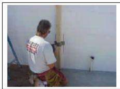
Крепление выравнивающей системы к блокам
