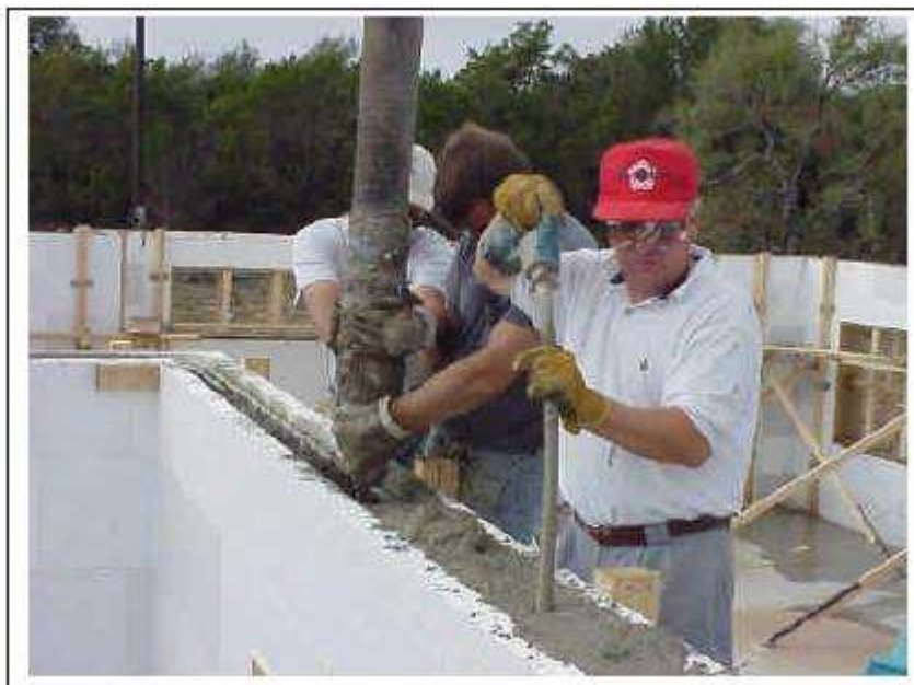
Заливка и виброобработка бетона
