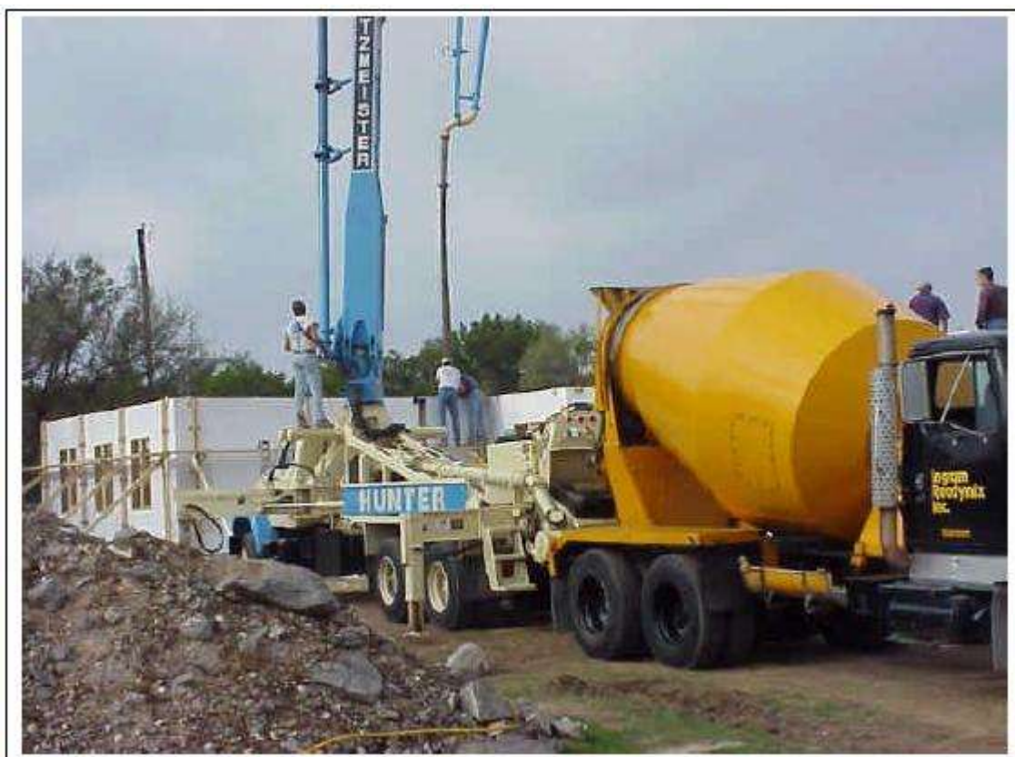
Заливка бетона стреловым насосом
