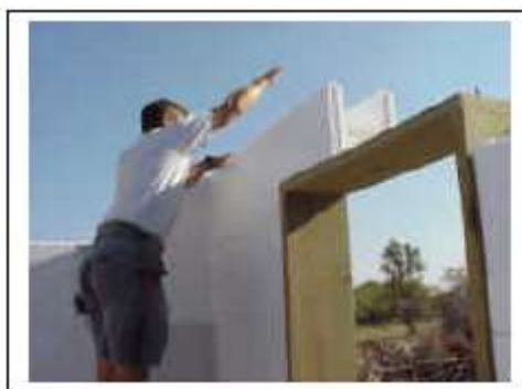
Установка блоков вокруг проема
