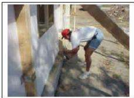
Проклейка наружной части стены
